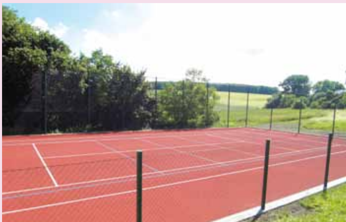
Srbsce po realizaci
